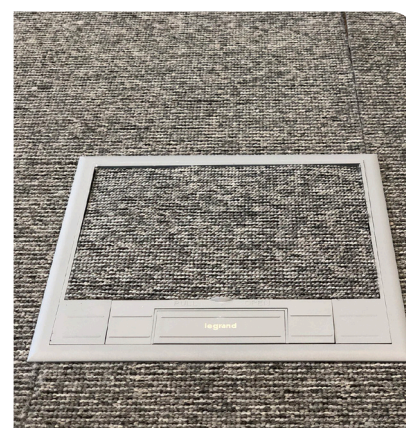
Corte do revestimento em esquadria
