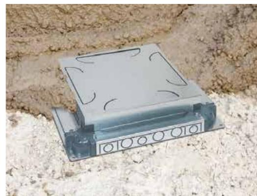
O betão é derramado diretamente em volta da caixa de encastrar até à altura pretendida (50 a 70 mm).
