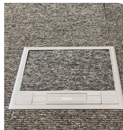
Corte do revestimento em esquadria
