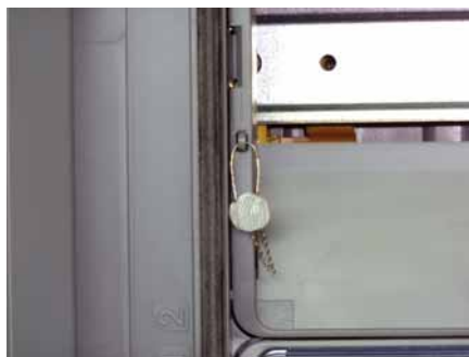
Plombage des plastrons
