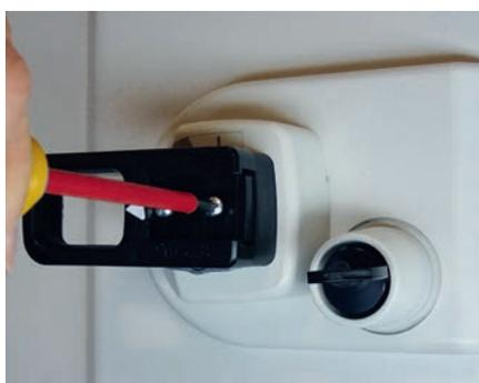
Adapter la longueur de l'axe suivant la distance porte-plastron/disjoncteur (se référer à la notice de montage de la commande rotative déportée).
