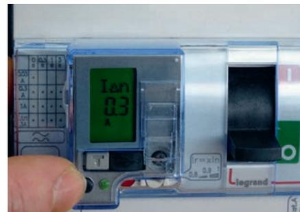
**i** L'unité de protection indique en face avant lorsqu'il faut changer les batteries.
